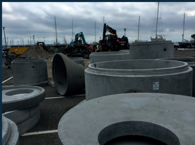
Vaskeområdets etape 1 er færdig
